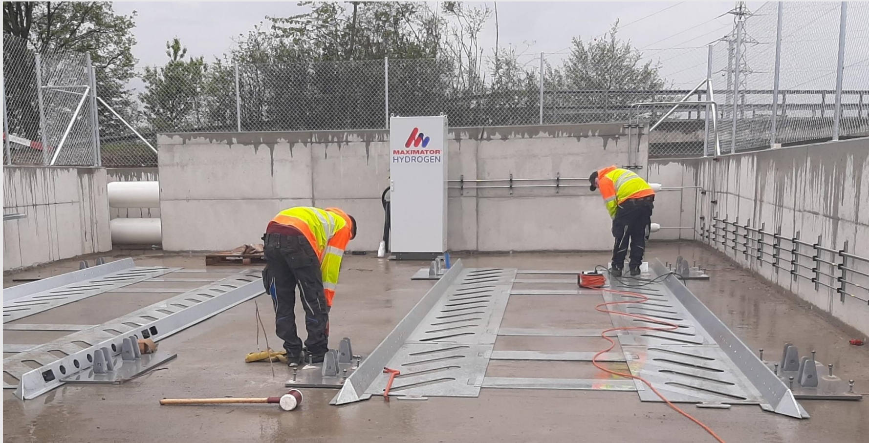
April 2023, Aufbau der Container Docking Stations an der SOCAR Wasserstoff-Tankstelle Grauholz Süd (BE)
